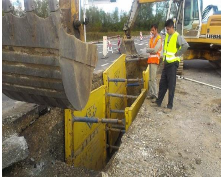
Figure 2.5 : Caissons métalliques.
