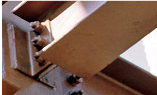
Figure 4.14 : Assemblage par double cornières
