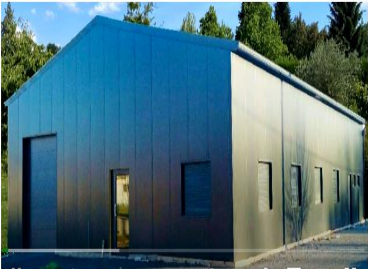
Photo 20 : Hangar en charpente métallique.
