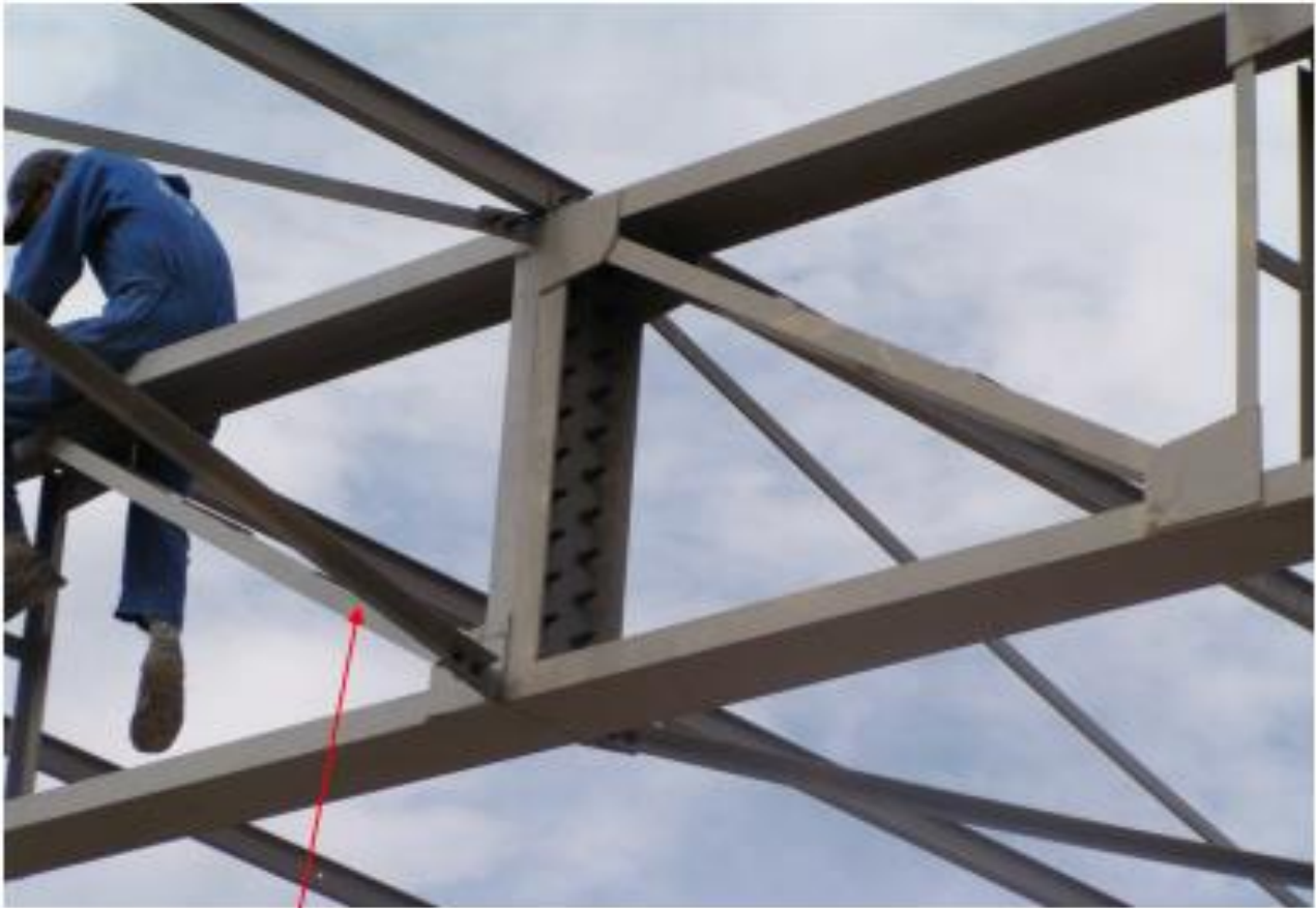
Montage des ciseaux longitudinaux
