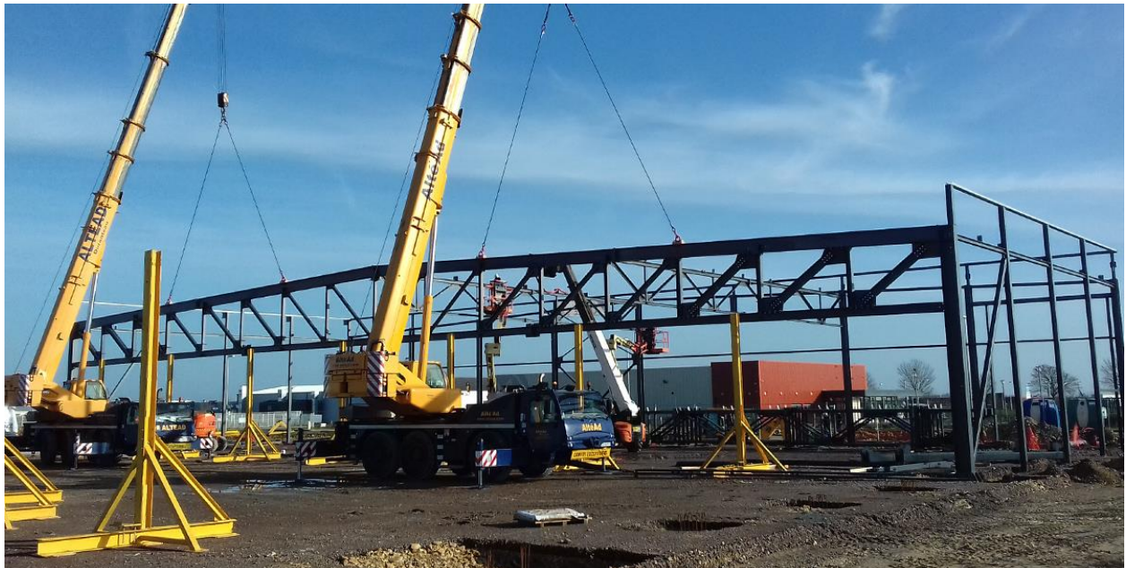
Photo 12 : Montage et mise en place d'une ferme en treillis.
