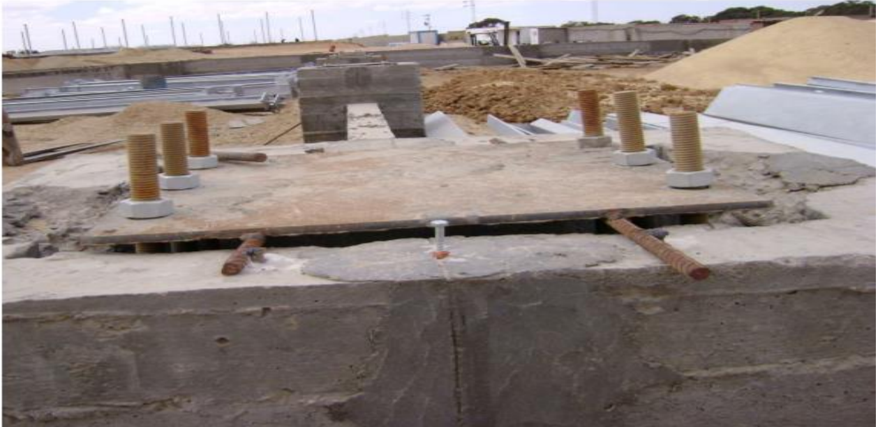
Photo 7 : Alignements longitudinal et transversal.
