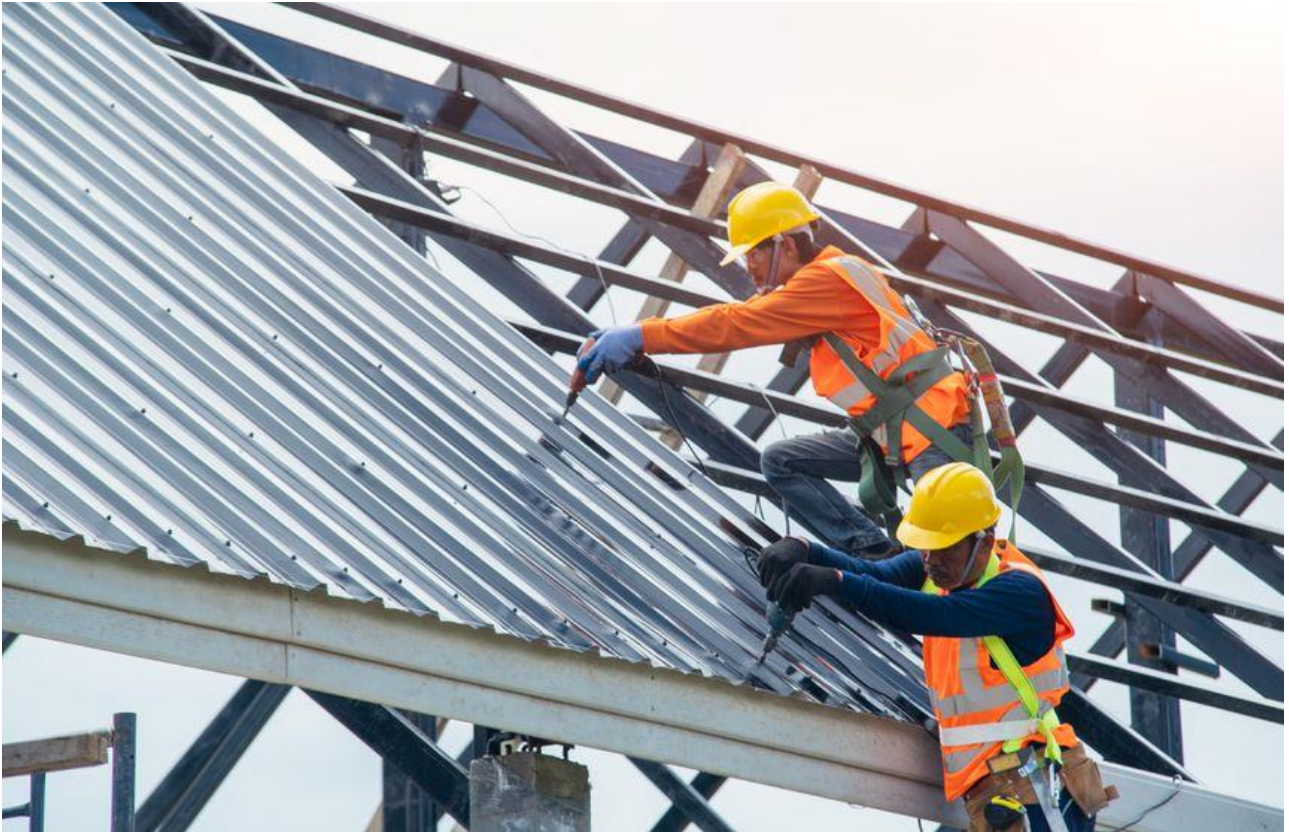
Photo 17 : Pose et fixation de la couverture.
