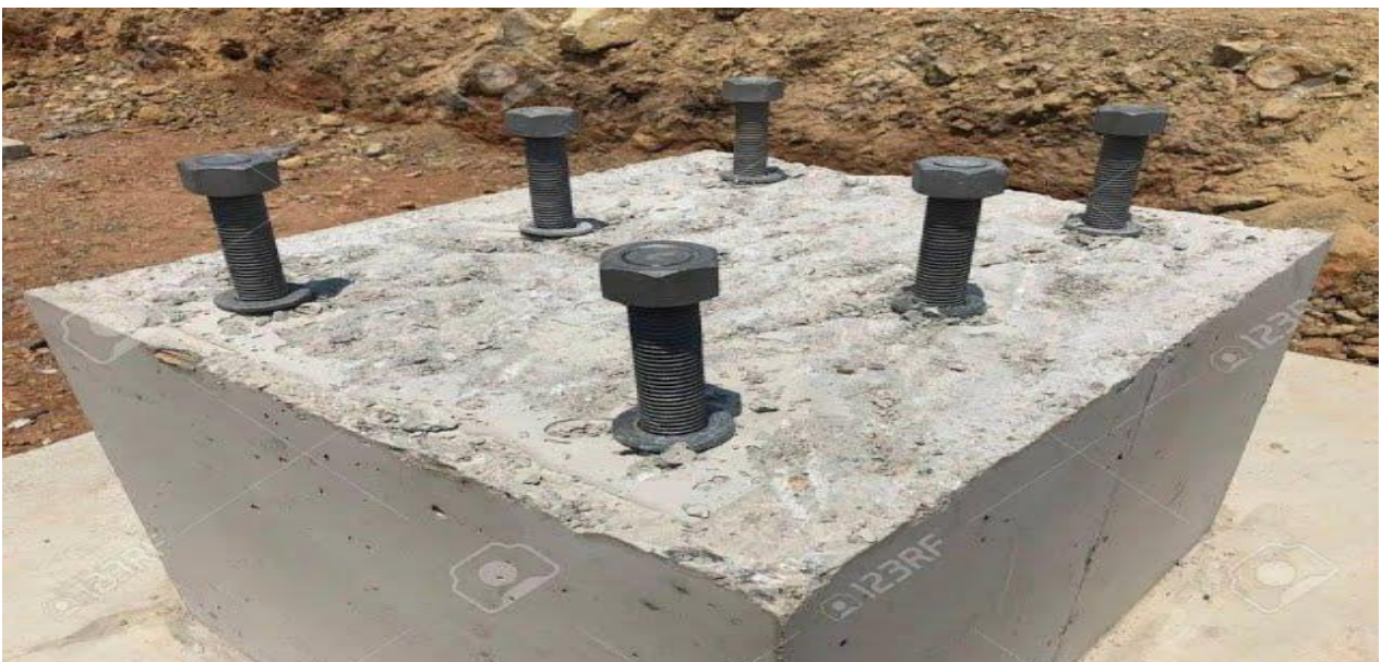
Photo 6 : Tiges d'ancrage d'un poteau encastré.
