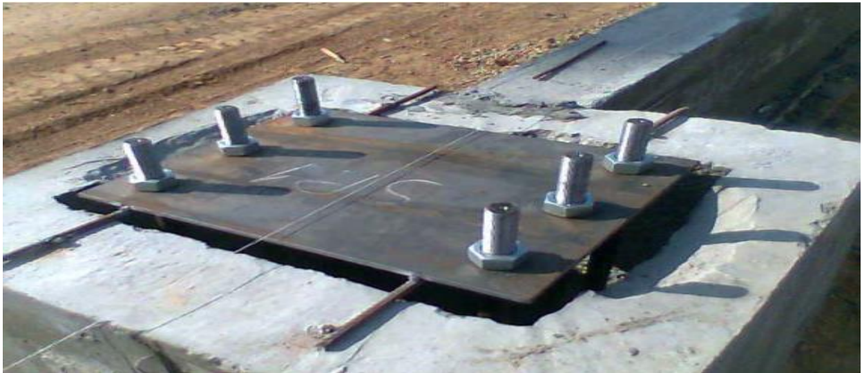
Photo 8 : Mise à niveau des platines.
