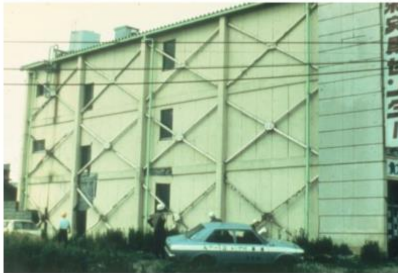
Figure 7.3: Contreventement par des barres en X.
