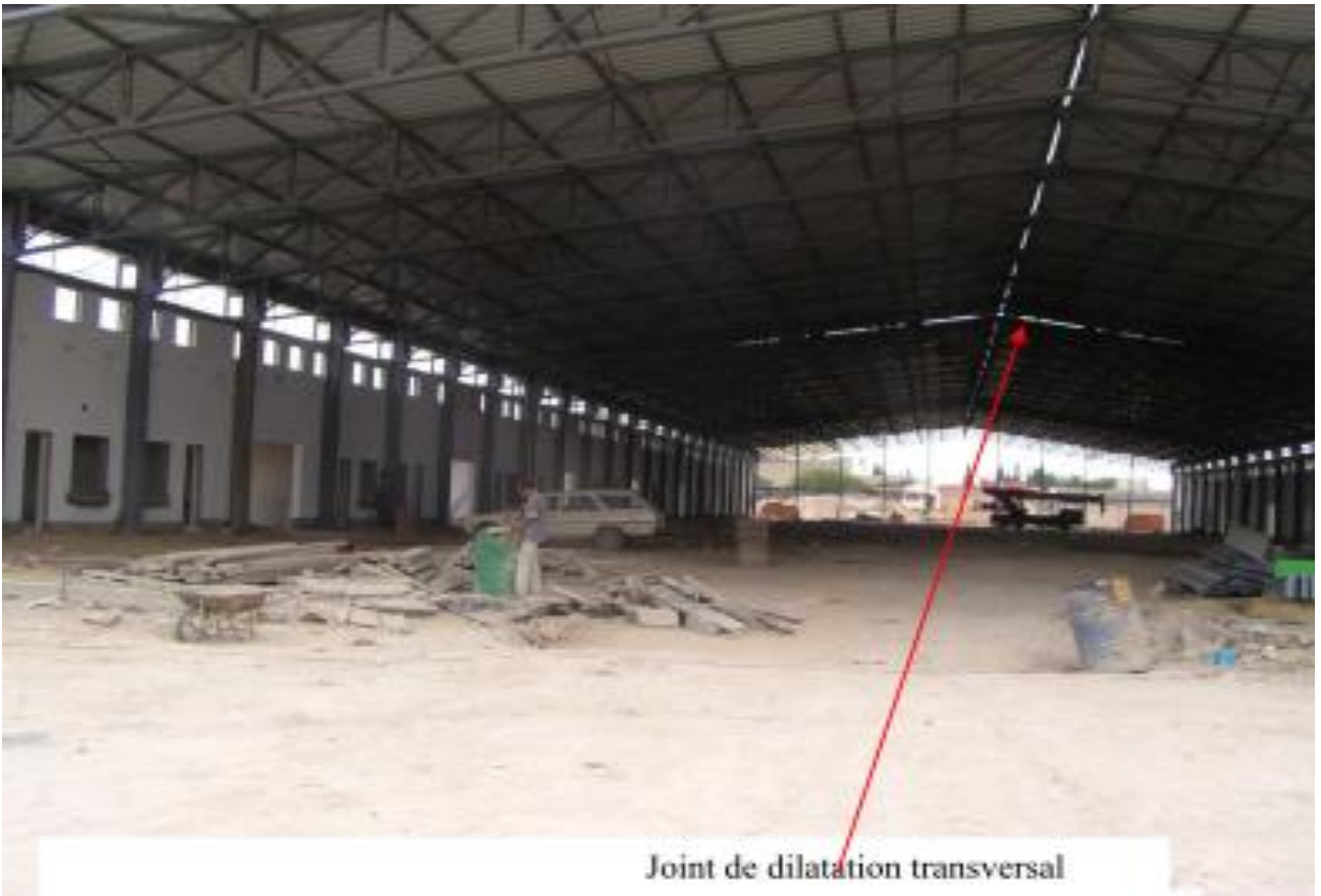
Photo 19 : Joint de dilatation transversal.
