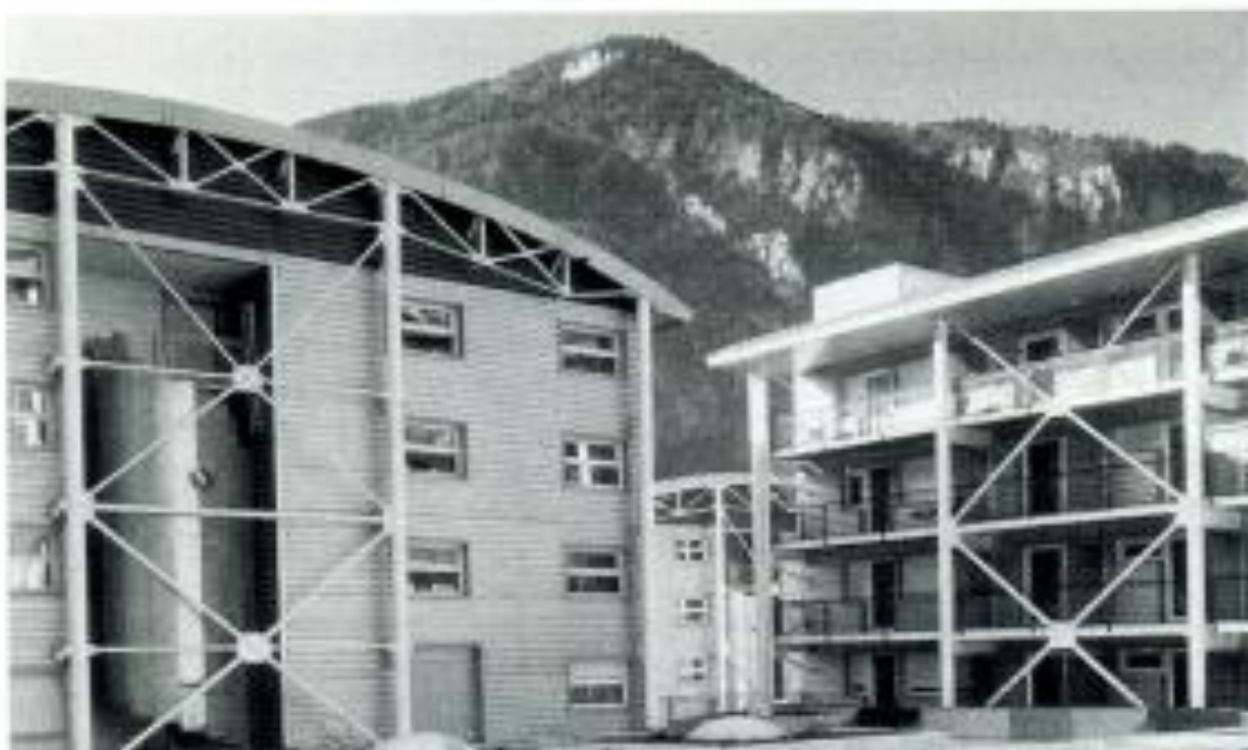
Figure 7.2 : Stabilisation par treillis de façade.
