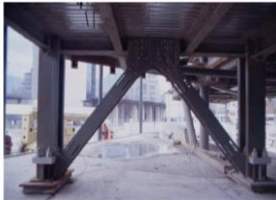
Figure 7.4: Contreventement par des barres en V.
