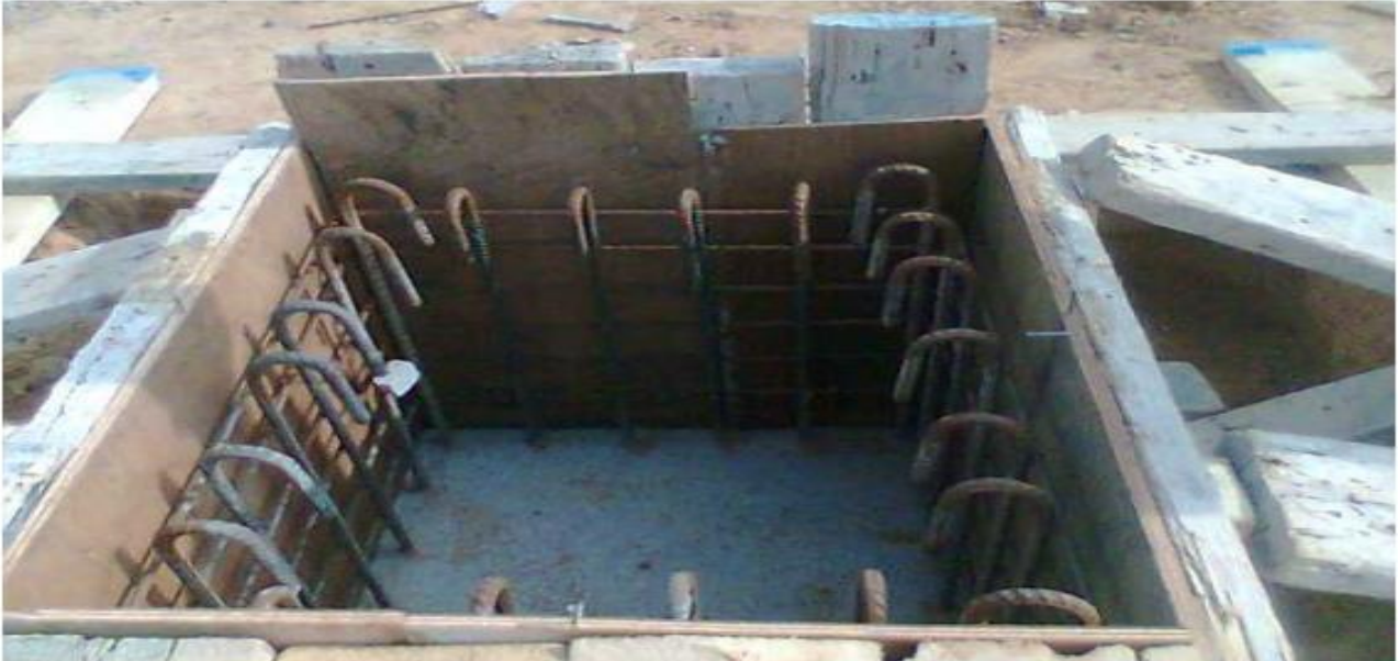
Photo 1 : Coffrage et ferrailage du fût.
