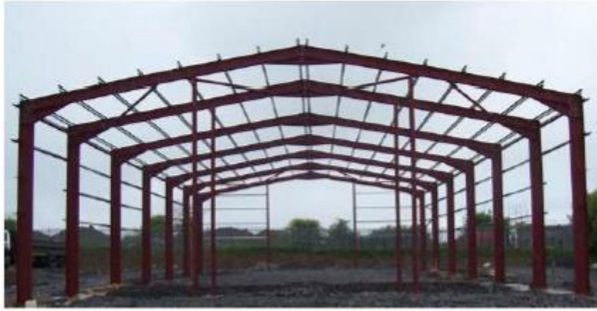
Figure 2.6 : Portique courant en profilés laminés à chaud
