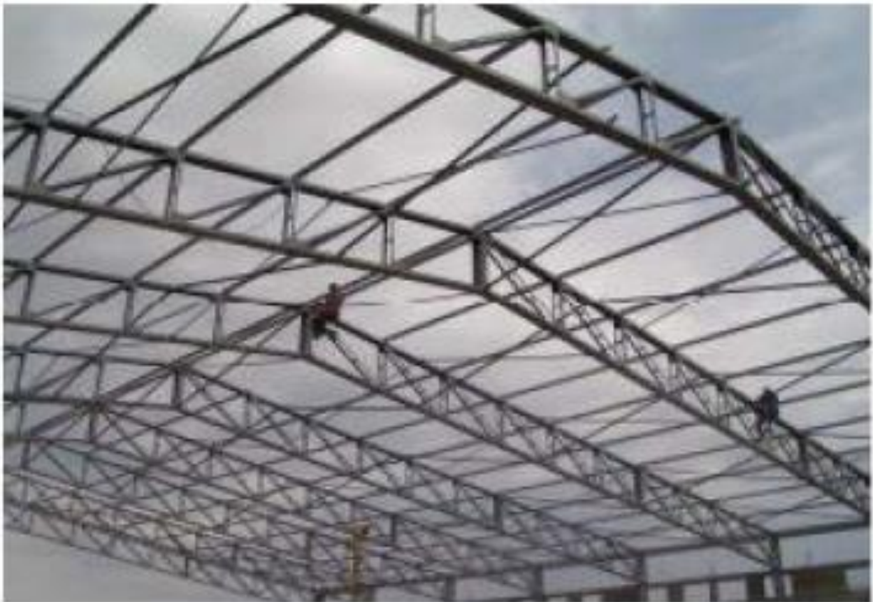
Photo 16 : Montage des ciseaux longitudinaux.
