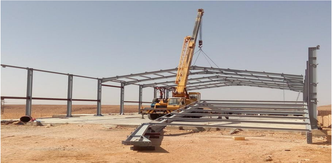
Photo 11 : Montage et mise en place des traverses avec grue.
