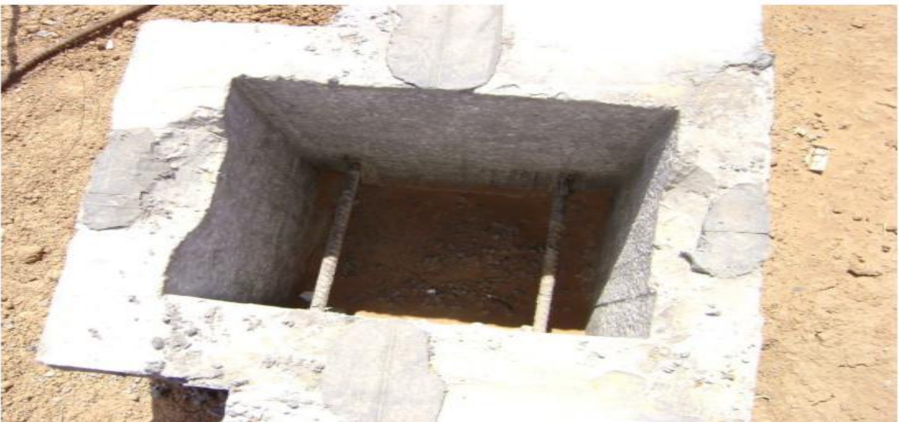
Photo 3 : Traçage des axes longitudinaux et transversaux & Clés d'ancrage anti-soulèvement.
