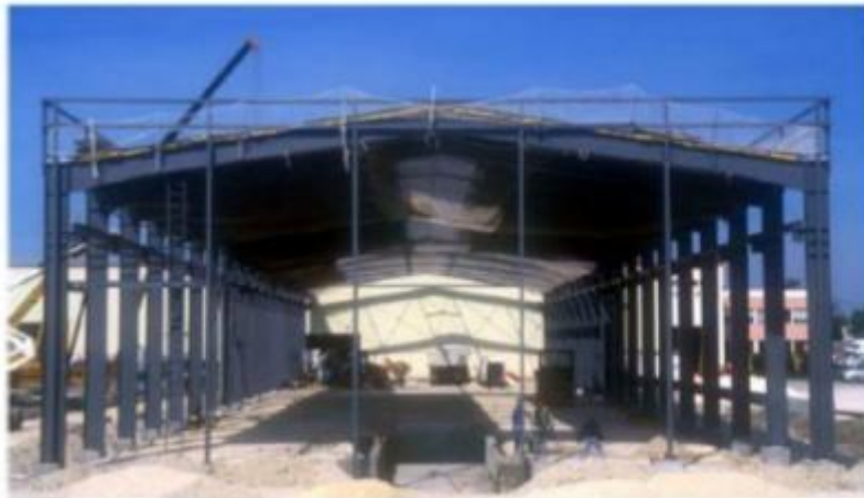
Figures 2.7 et 2.8: Portiques courants en profilés reconstitués soudés
