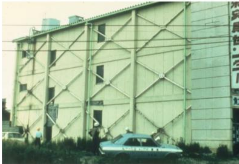
Figure 7.3: Contreventement par des barres en X.
