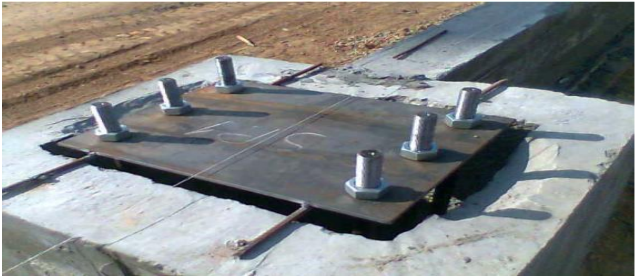
Photo 8 : Mise à niveau des platines.
