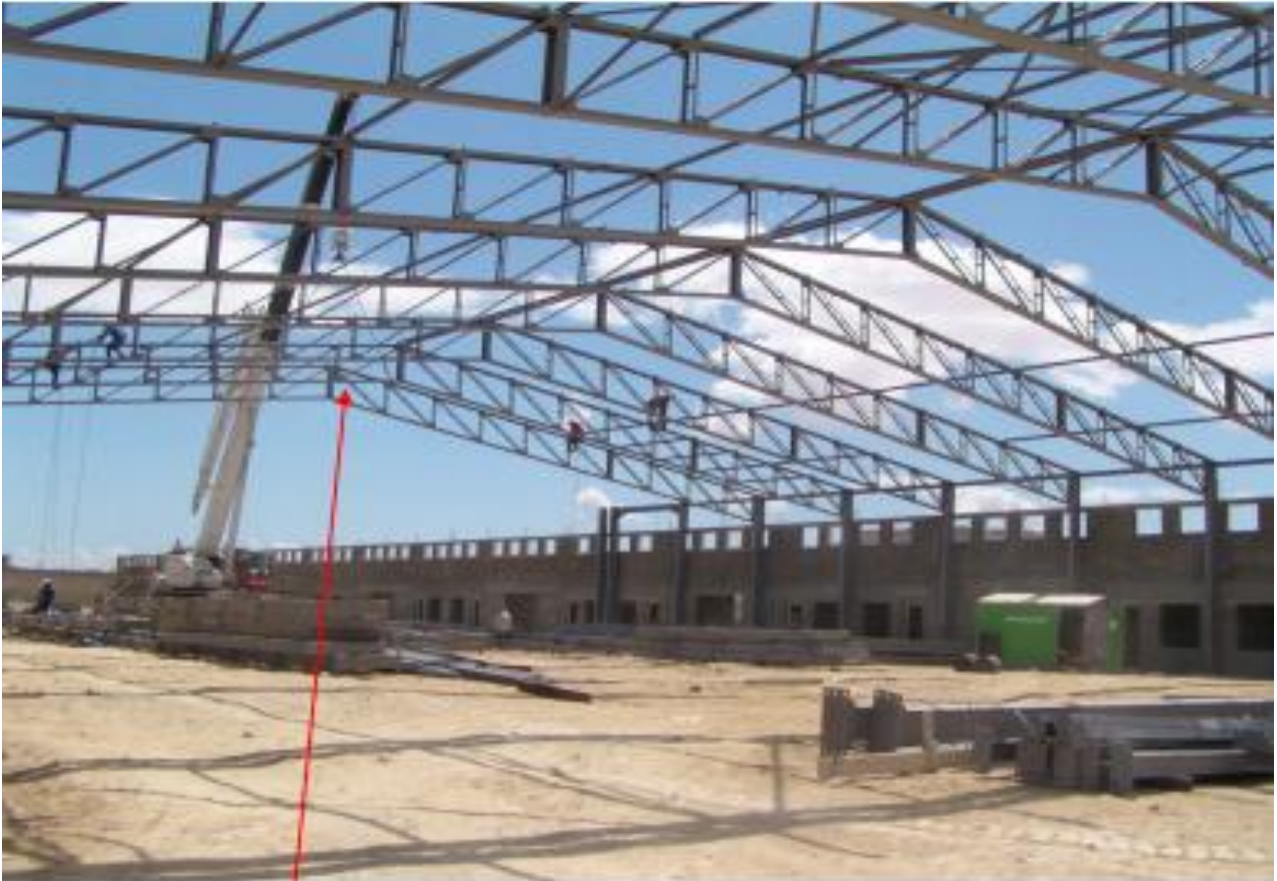
Montage de la ferme positionnement avec la grue
