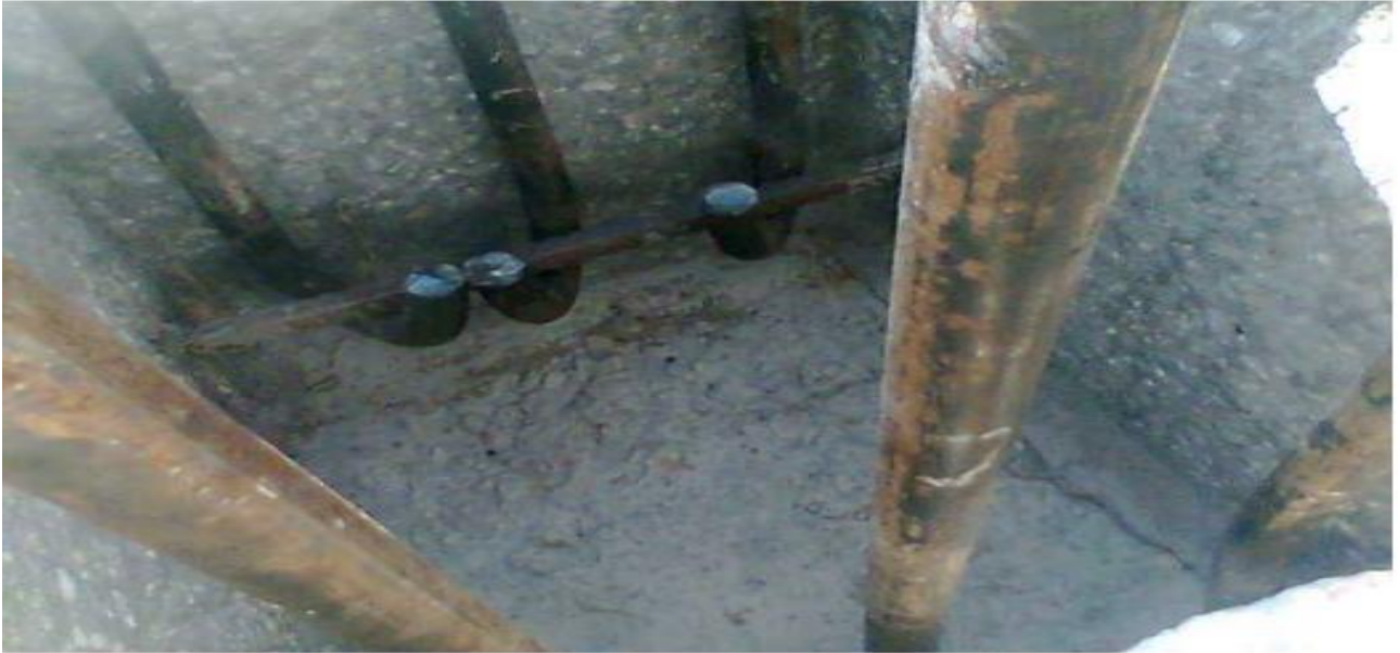
Photo 4 : Mise en place des crochets à bouts filetés.
