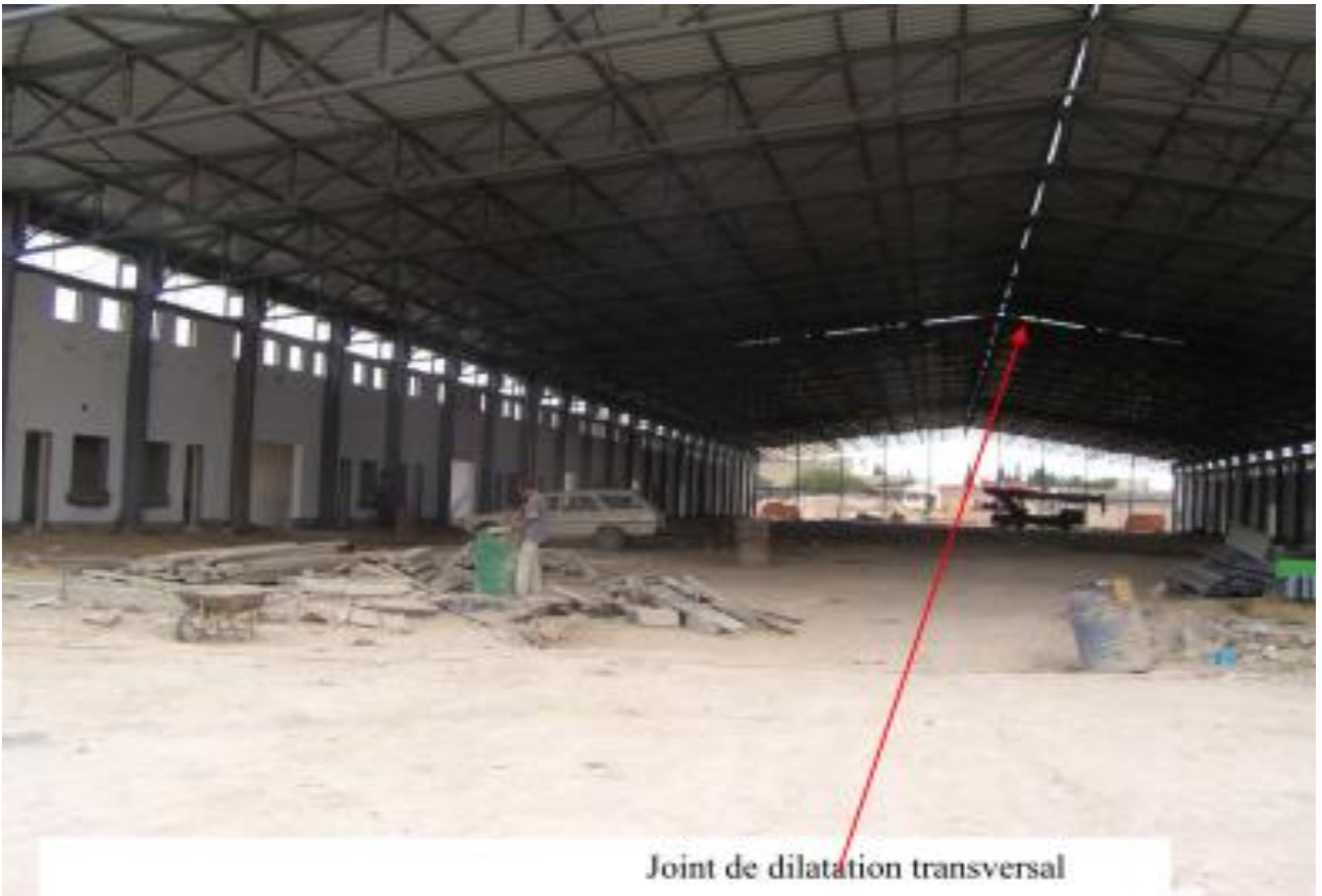
Photo 19 : Joint de dilatation transversal.
