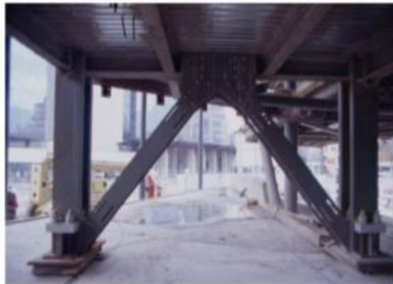
Figure 7.4: Contreventement par des barres en V.
