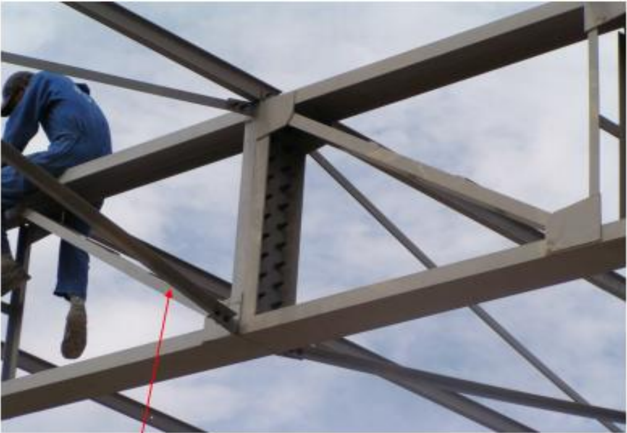
Montage des ciseaux longitudinaux
