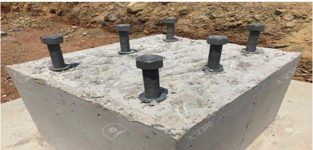
Photo 6 : Tiges d'ancrage d'un poteau encastré.
