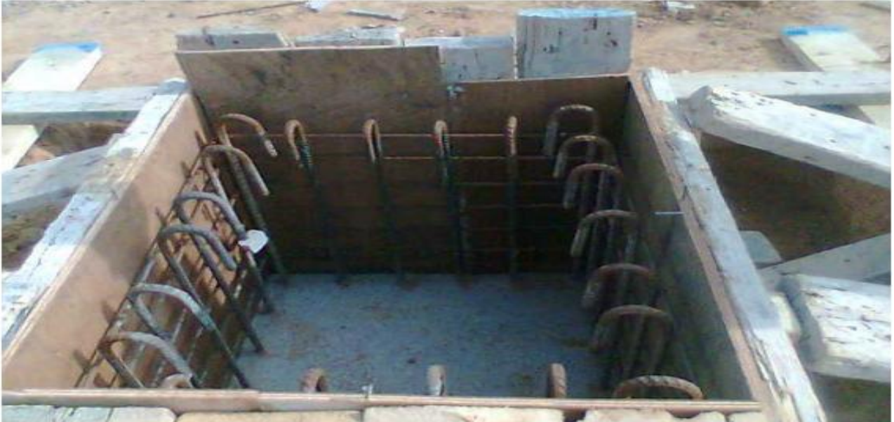
Photo 1 : Coffrage et ferrailage du fût.
