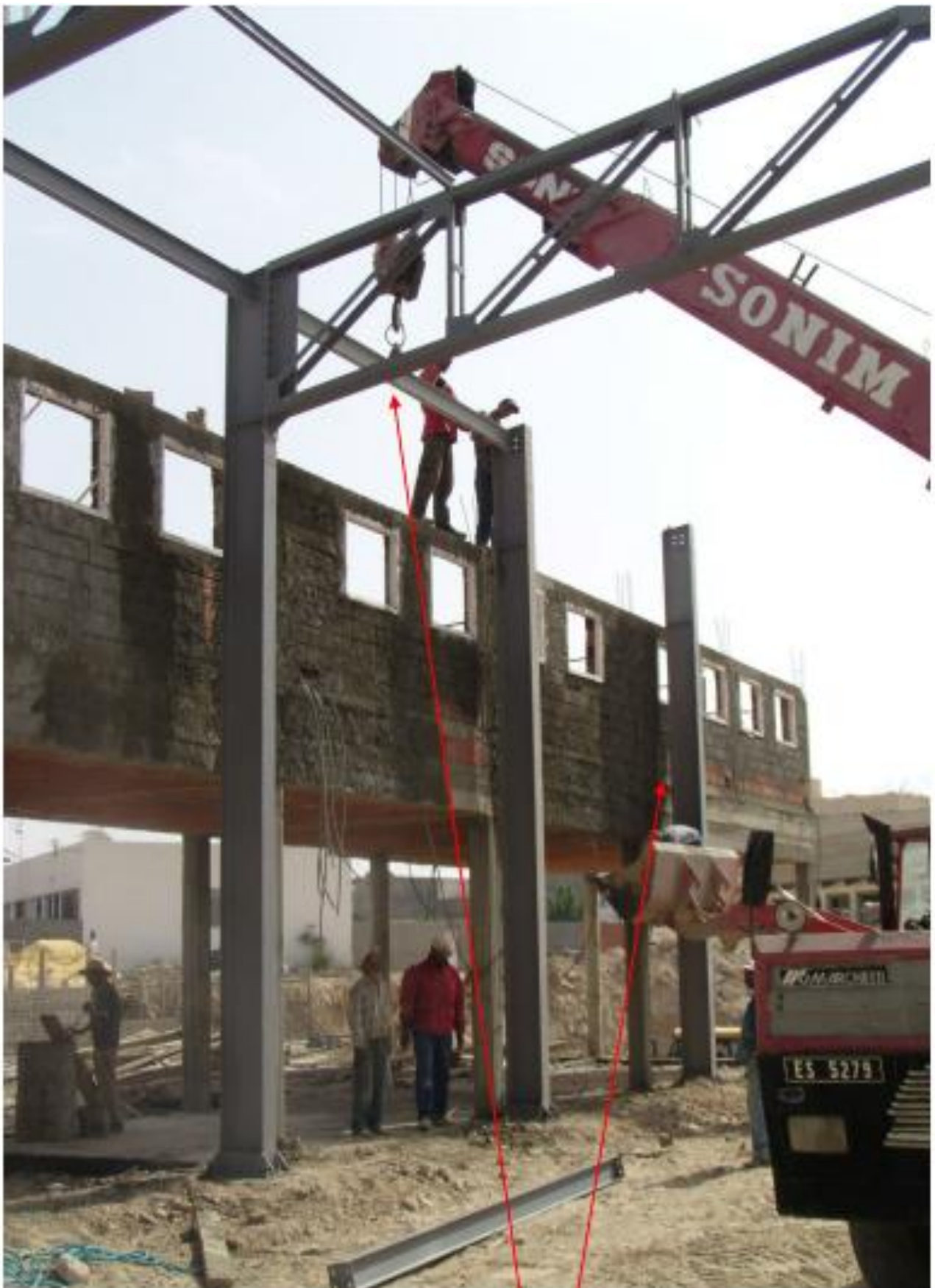
Mise place des poteaux en profilés Mise en place des sablières
