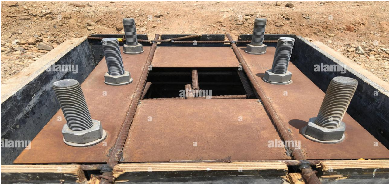
Photo 5 : Pose des tiges d'ancrage avant coulage du béton.
