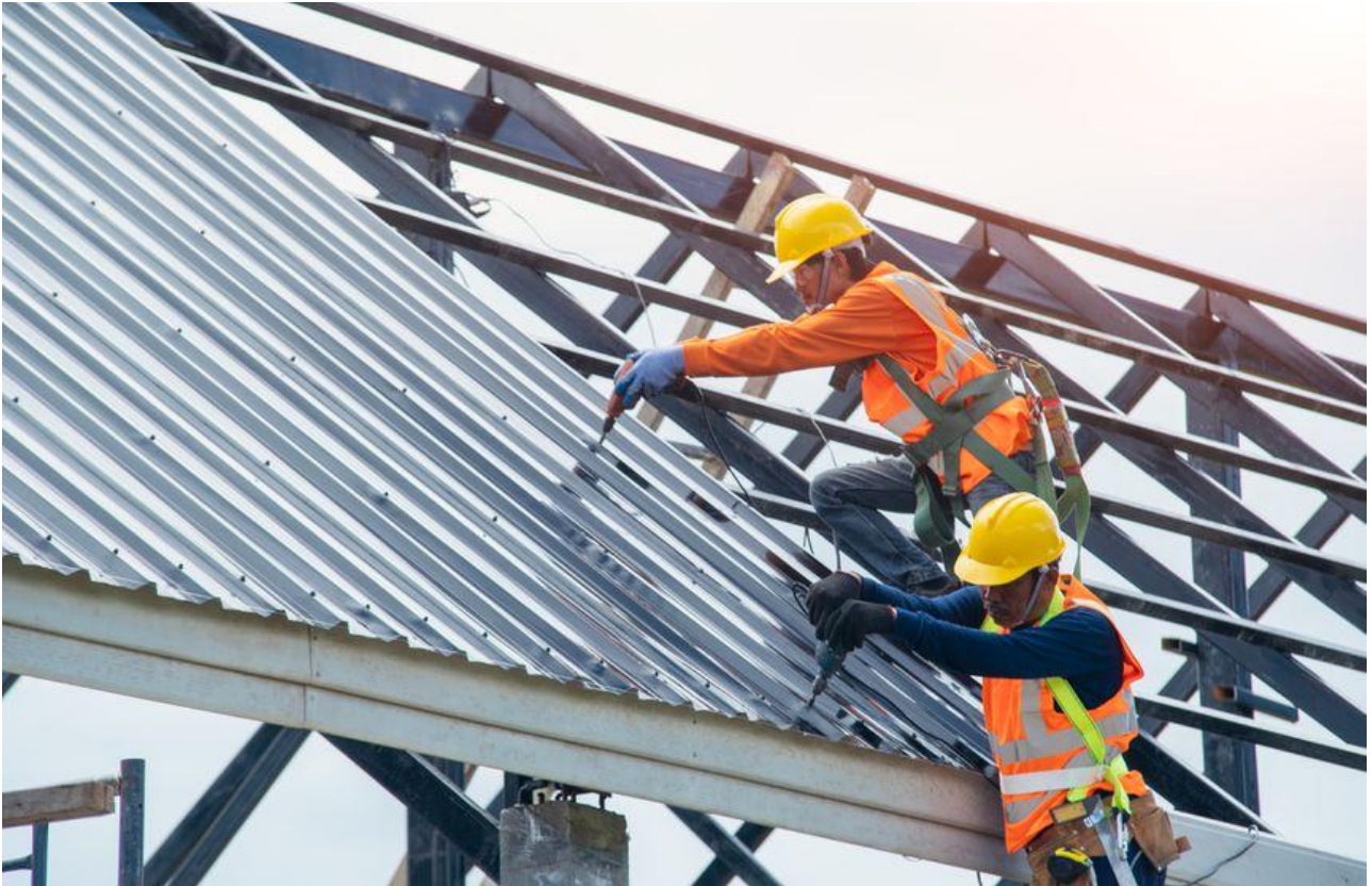
Photo 17 : Pose et fixation de la couverture.
