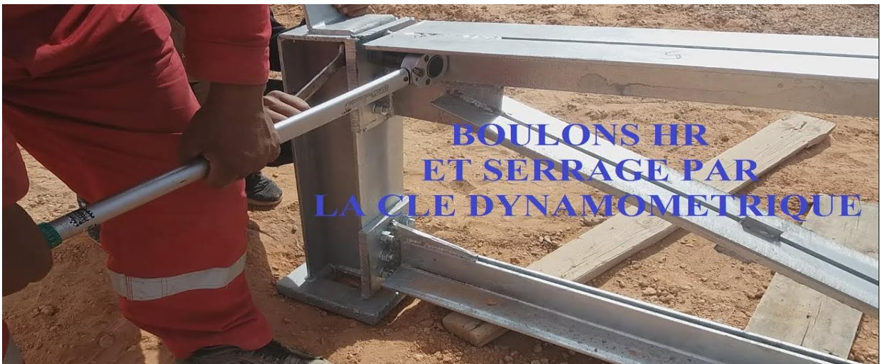
Photo 13 : Serrage des boulons HR par la clé dynamométrique.
