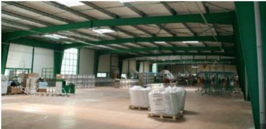
Figure 2.6 : Portique courant en profilés laminés à chaud
