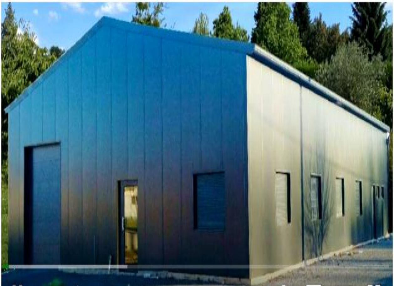
Photo 20 : Hangar en charpente métallique.
