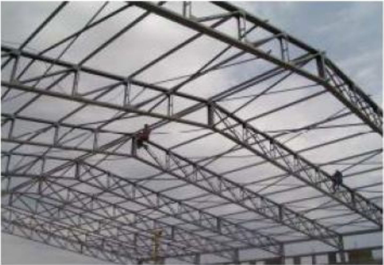
Photo 16 : Montage des ciseaux longitudinaux.
