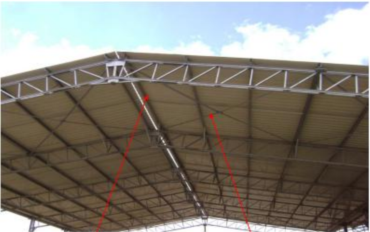
Photo 17 : Pose et fixation de la couverture.
