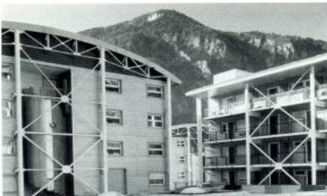
Figure 7.2 : Stabilisation par treillis de façade.
