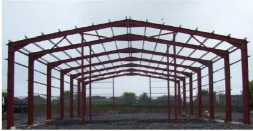
Figure 2.6 : Portique courant en profilés laminés à chaud
