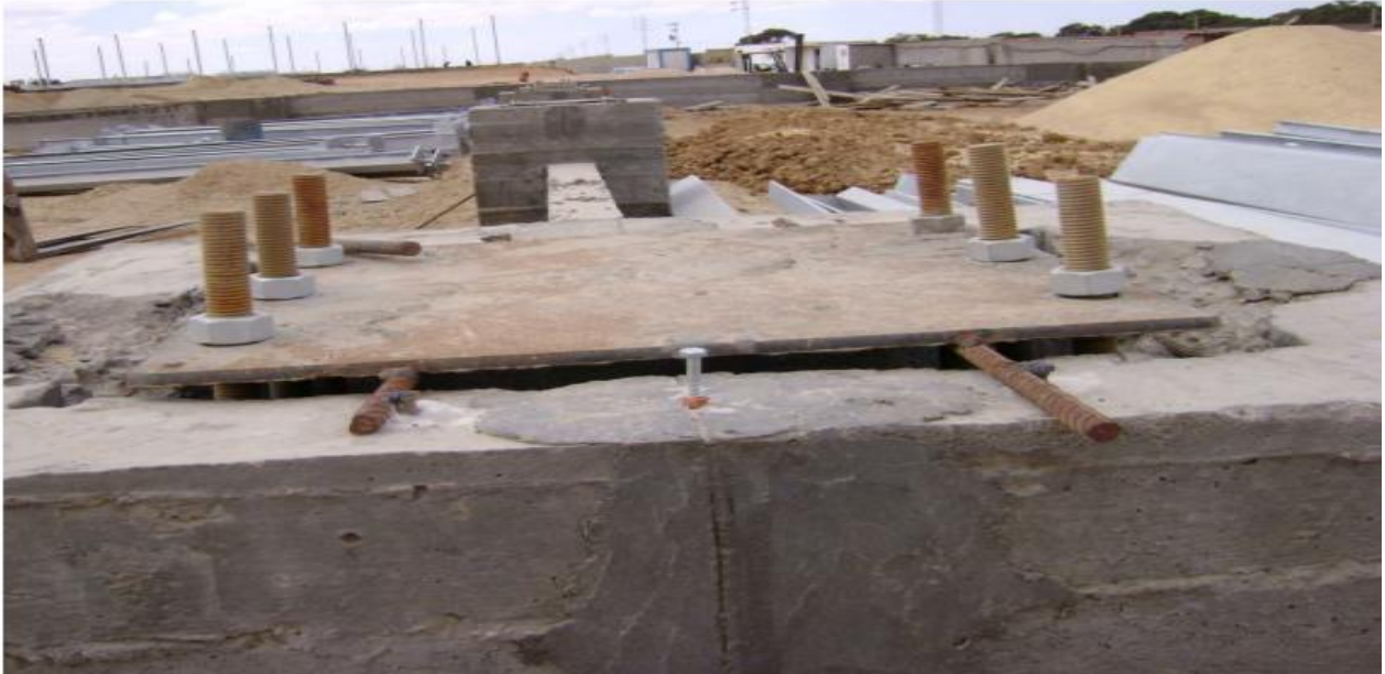
Photo 7 : Alignements longitudinal et transversal.
